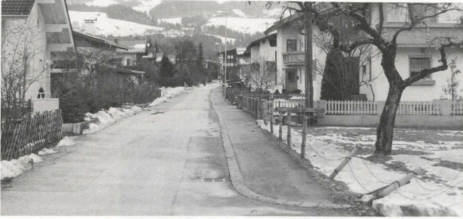
Gehsteig Tafang verbessert die Verkehrssicherheit
