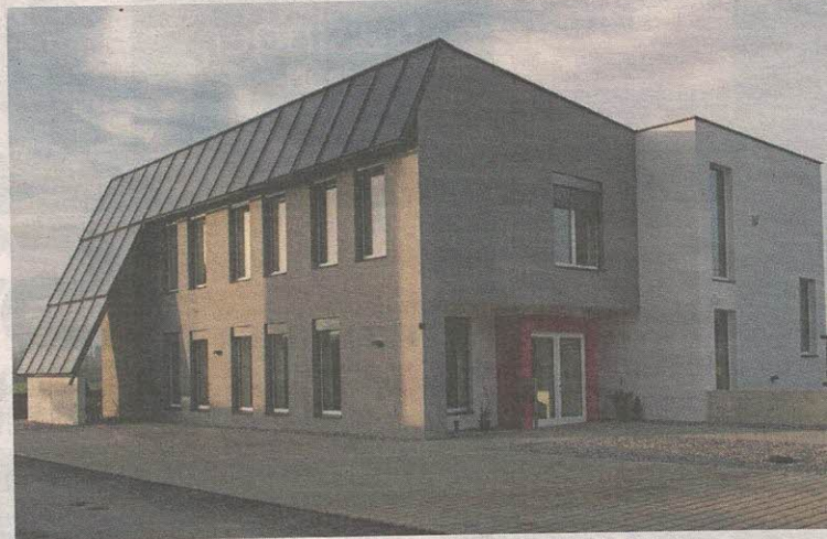
Unser neues Bürogebäude erfüllt den Passivhausstandard und wird mit Sonnenenergie beheizt.
