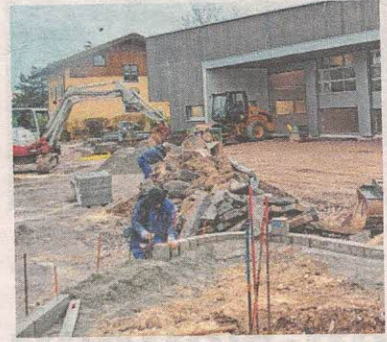
Derzeit wird emsig an der Zufahrt zum Neubau gewerkt.
