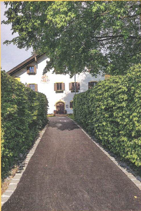
Nicht nur Großprojekte stehen im Fokus: Bei der Neugestaltung des Pfarrergässls wurden Stolperfallen entschärft und vor allem auf Barrierefreiheit geachtet.
