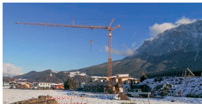
Seit dem Baubeginn Anfang Dezember schreiten die Arbeiten voran.
