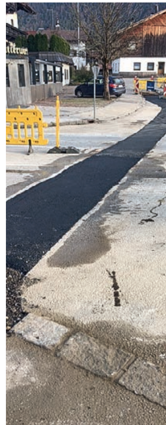
Die Querung der B175 konnte bereits rasch nach den Grabungsarbeiten mit Asphalt befestigt werden.
