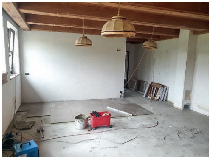
Es konnte bereits wieder mit dem Innenausbau begonnen werden.
