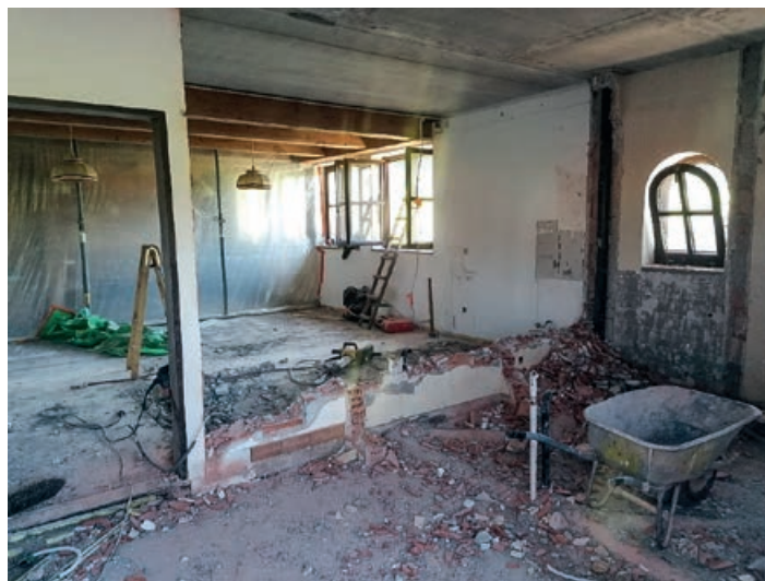
Die Umbauarbeiten im Feuerwehrhaus der Feuerwehr Buchberg sind voll im Gange.
