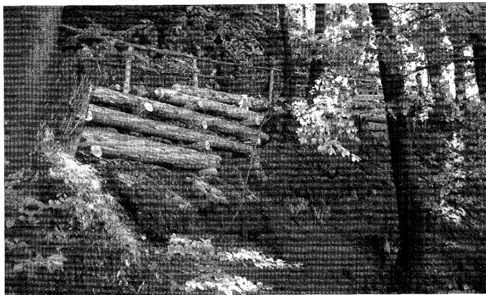
Neue Krainerwand am Kaiseraufstieg gibt wieder Sicherheit
