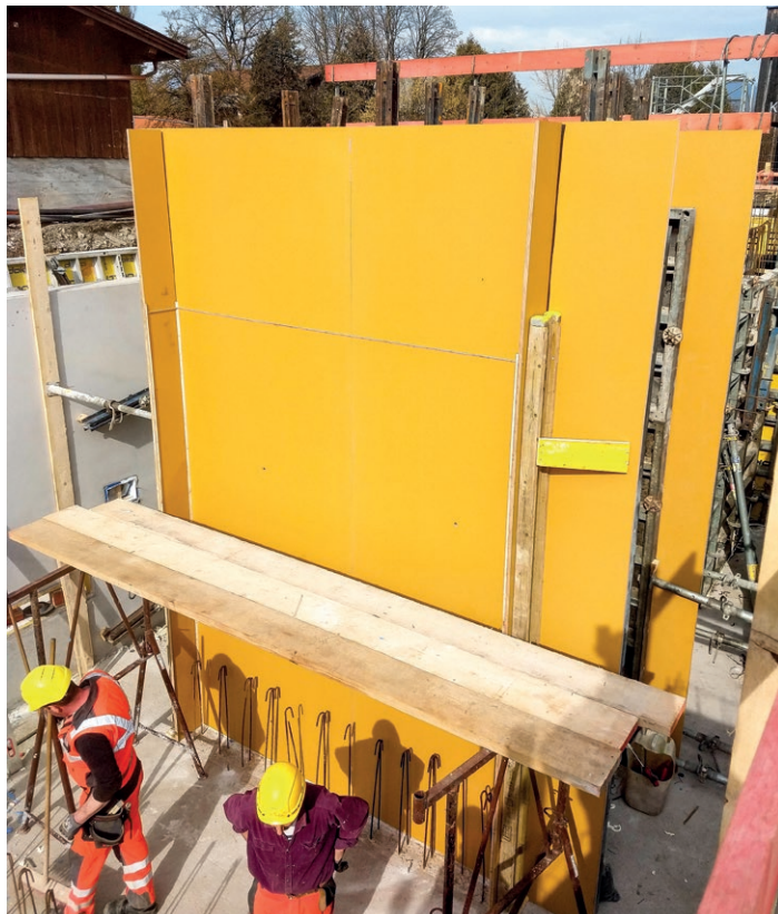
Belegte Stahlschalung für die Erstellung der Sichtbetonwände.
