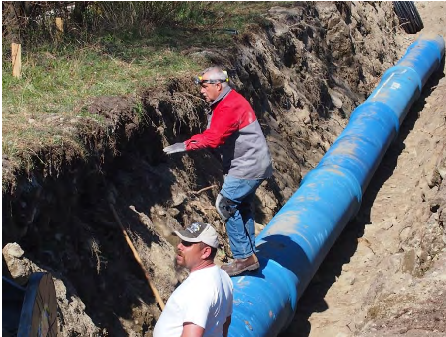
Ende Februar begannen die Vorbereitungen für die Verlegung der Rohrleitungen für das neue Kraftwerk ...
