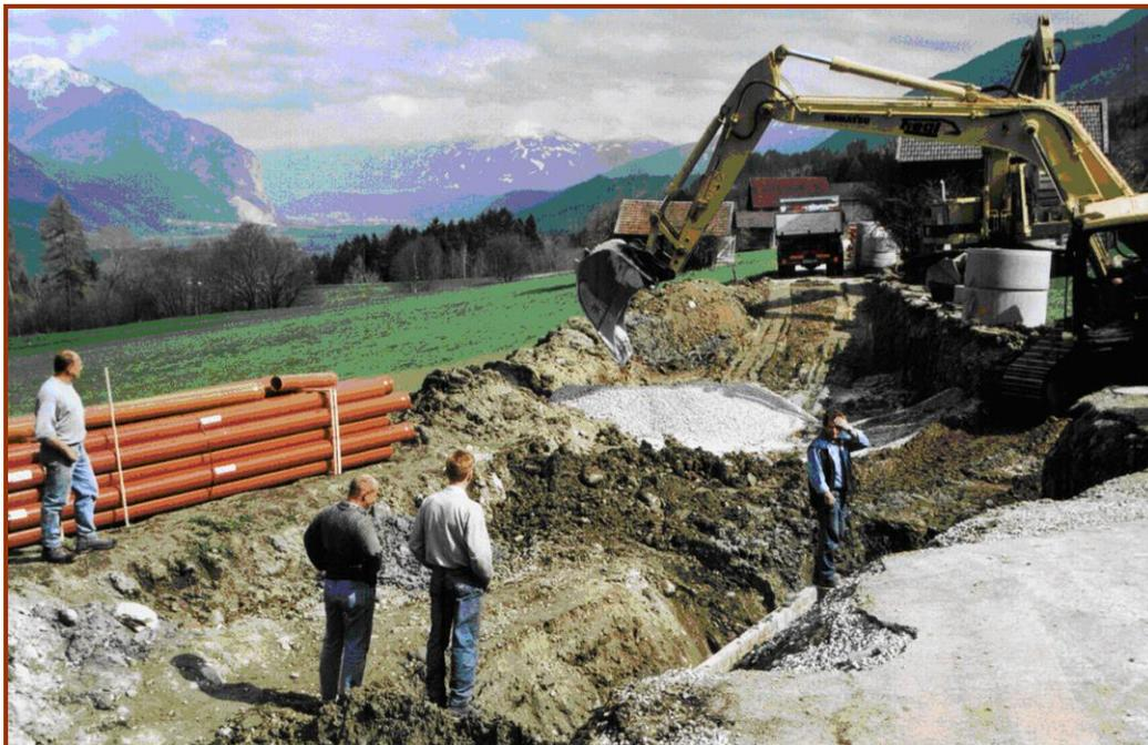
Um ein entsprechendes Gefälle für die Abwasserrohre zu erreichen, mussten diese an einer Stelle fast 8 m tief in den Boden versenkt werden.
