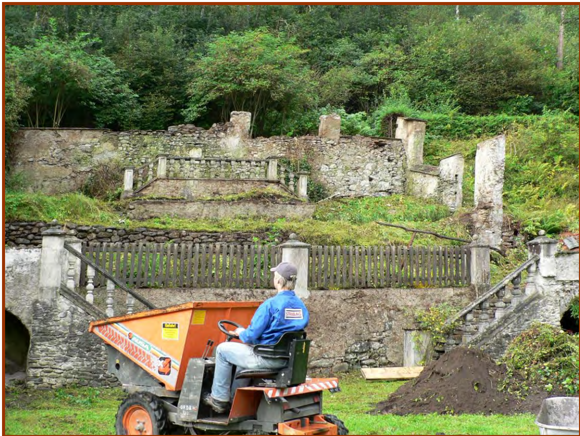
Der Barockgarten bei Beginn der Sanierungsarbeiten im August 2006
