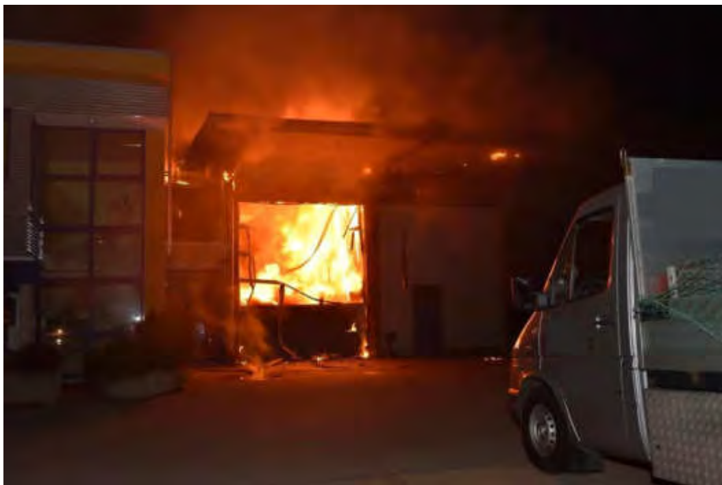
Die Lagerhalle stand in Vollbrand und drohte auf das südlich vorgebaute Bürogebäude samt Betriebswohnung überzugreifen.
