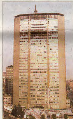
Der beschädigte Pirelli-Turm. Foto: EPA, ANSA/Dal Zennaro
