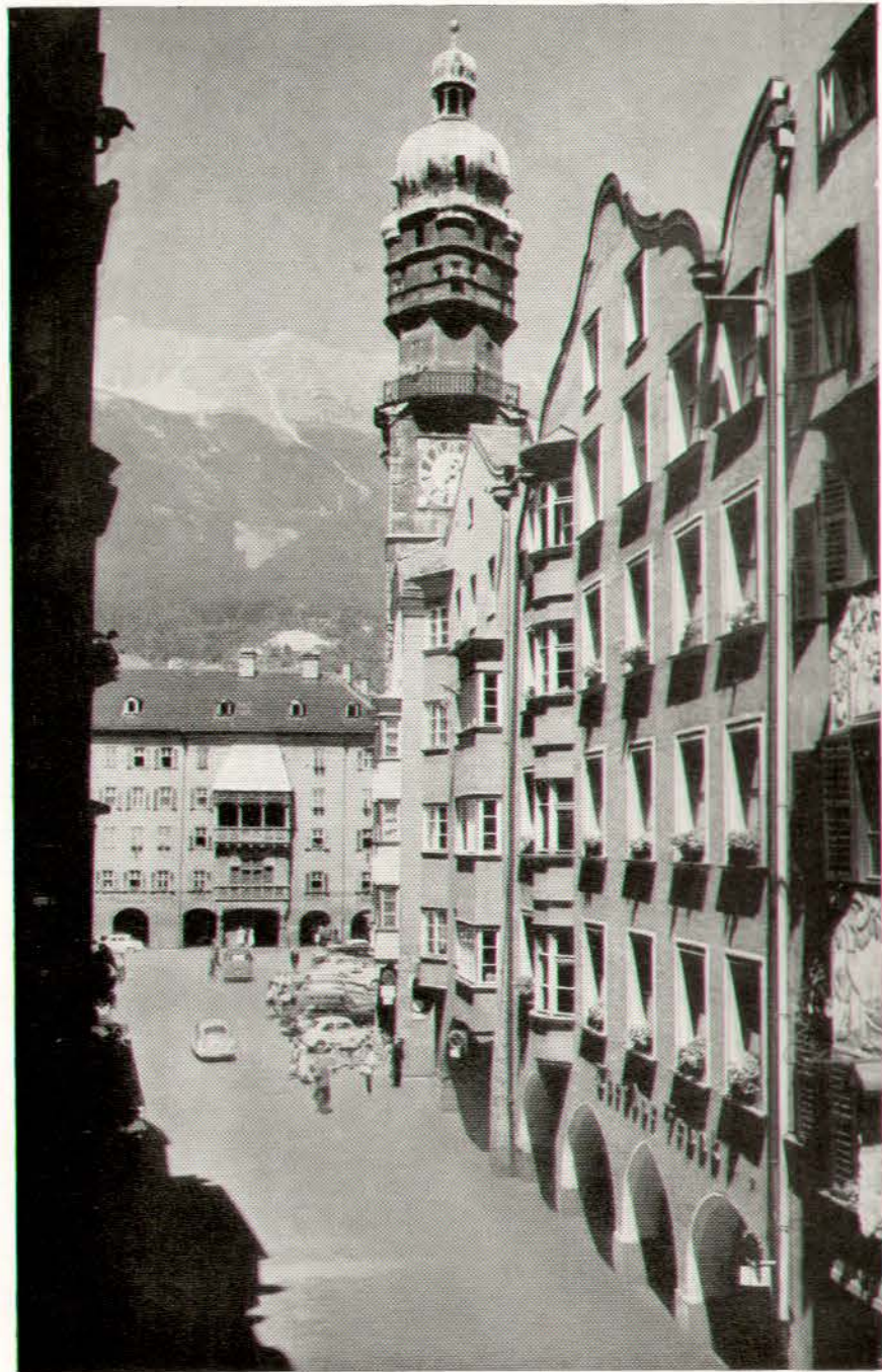
Das Geschäftshaus in der Altstadt von Innsbruck (Aufnahme 1961)
