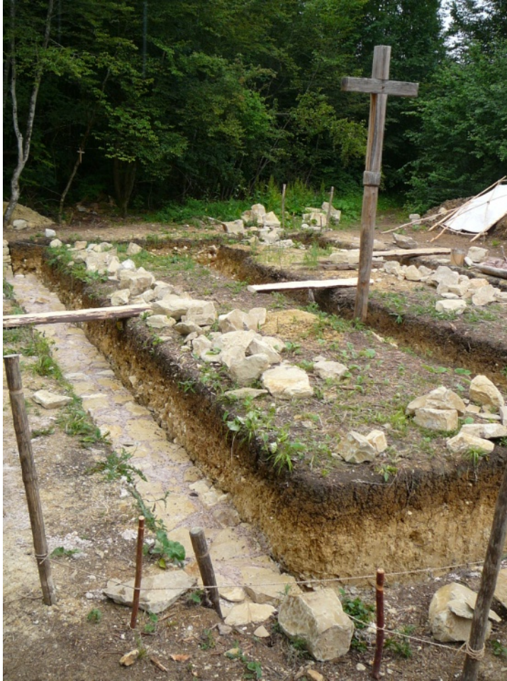
Abbildung 4 Steinfundament, wie es für eine kleine Steinkirche benötigt wird [vom Gelände des Campus-Galli]
