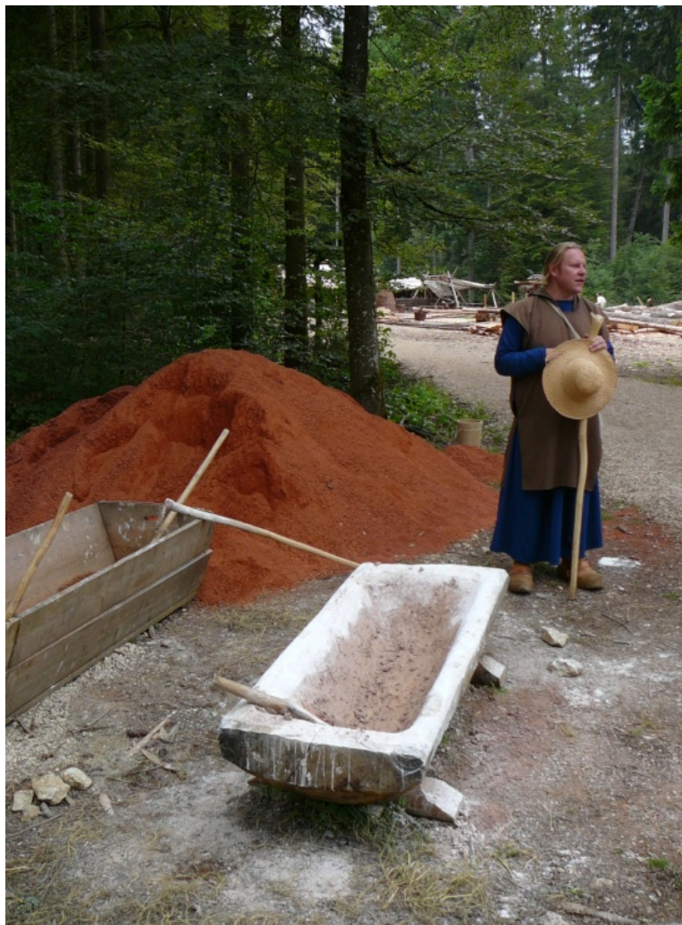
Abbildung 3 Mörtelmischen mit Ziegelmehl, Kalk und Sand in einer Holz-Molle [vom Gelände des Campus-Galli]
