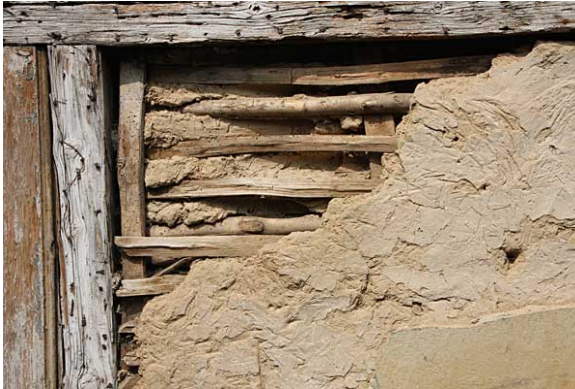
Abbildung 17 Ausfachung an modernem Gebäude in Quedlinburg
