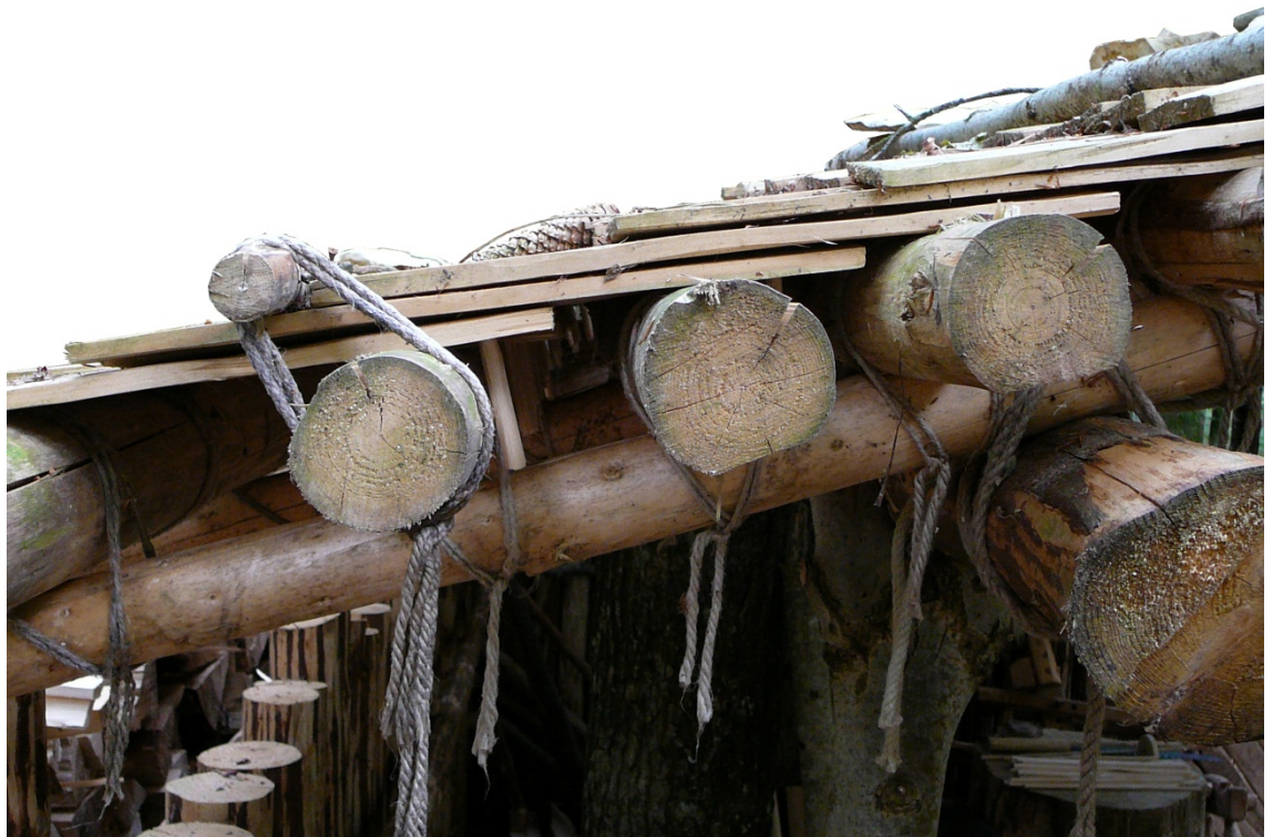
Abbildung 16 Fichten-Schindeldach mit Kernholz-Holznägel befestigt [vom Campus-Galli-Gelände]
