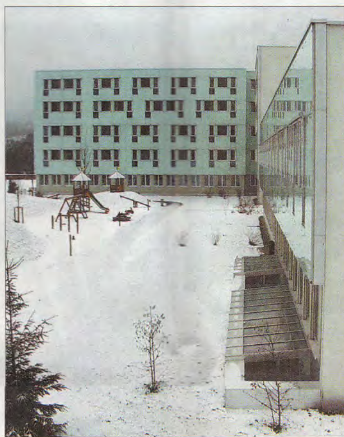
TIEF VERSCHNEIT: Das neue Bezirkskrankenhaus Kufstein wurde im Oktober eröffnet. TT-Foto: Zenhäusern
