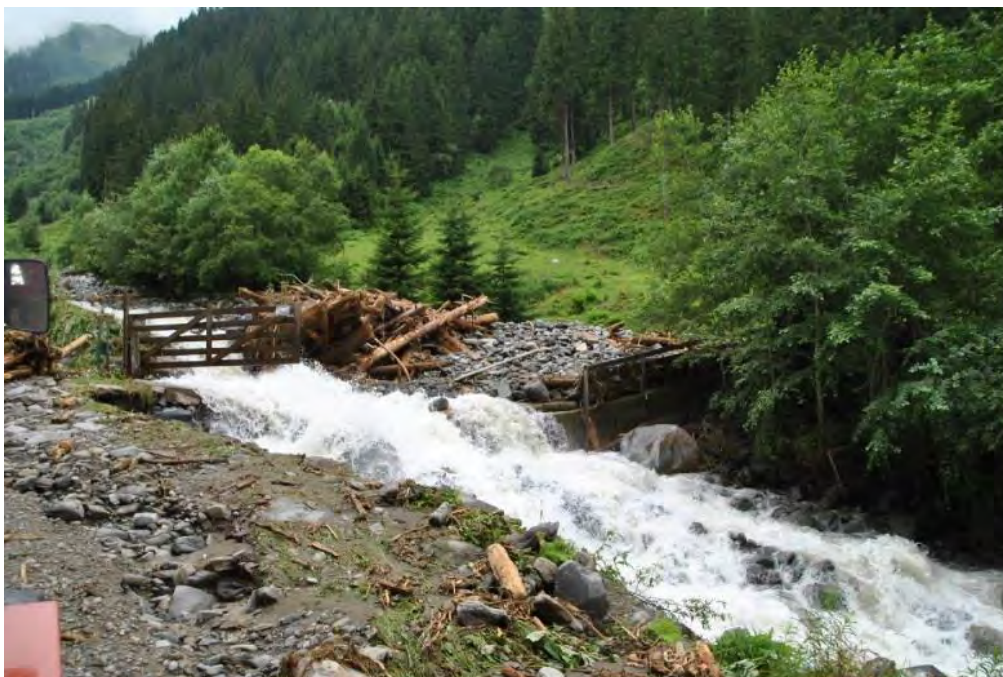
Mure vom Tieftal bis zur Kohlerbrücke des Kanzingbaches
