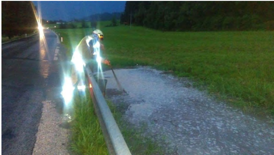
Auspumparbeiten und Öffnen des Einlaufgitters
