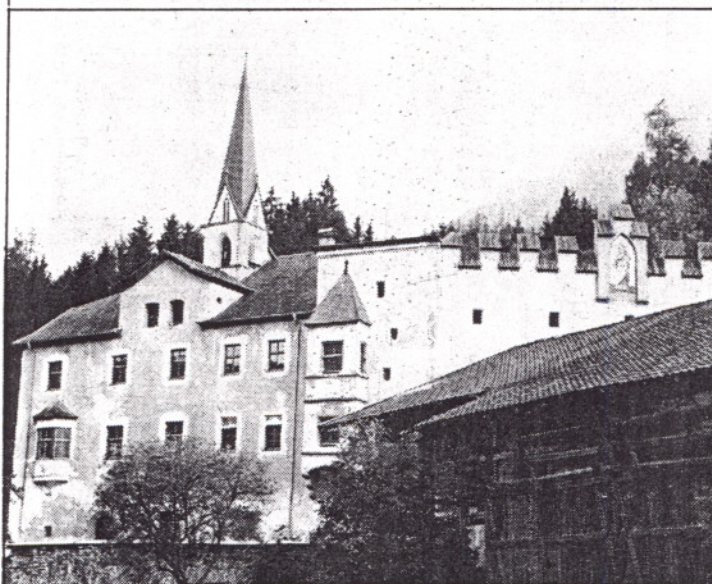
Der bedeutendste Widumkomplex Tirols befindet sich in Flauring.
