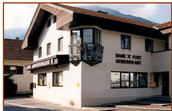
Das 1960/61 errichtete RAIKA – Gebäude mit Post und Gemeindeamt
