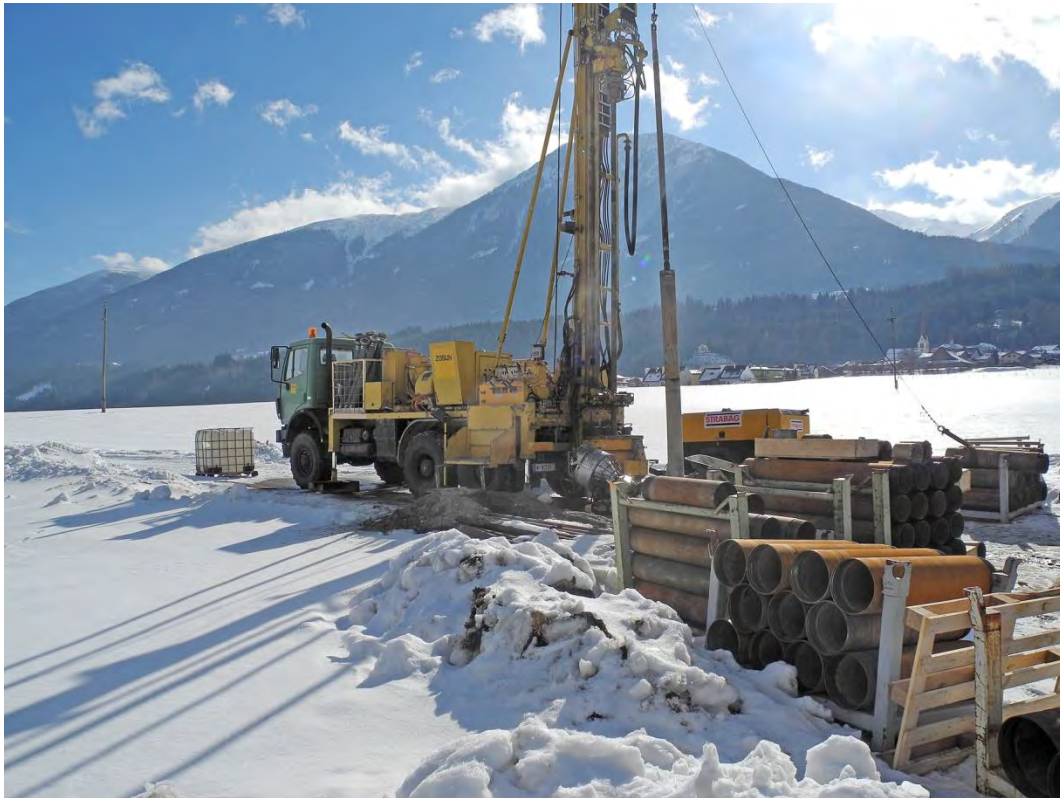
Bohrmaschine im Einsatz zur Entnahme von Bodenproben
