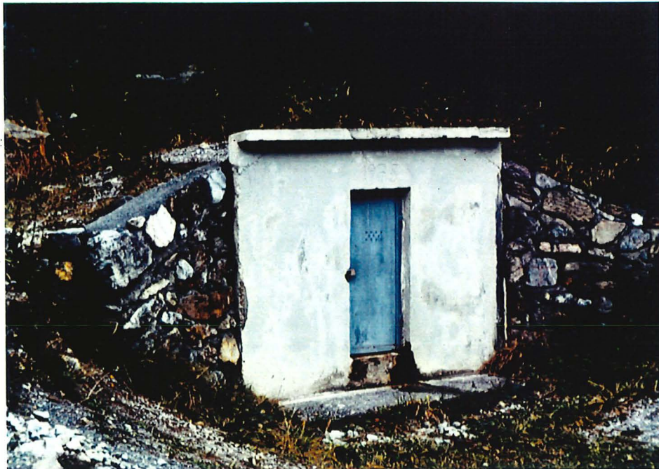
Untere Brunnenstube mit getrennten Kammern für die Quellen I und II, erbaut 1975
