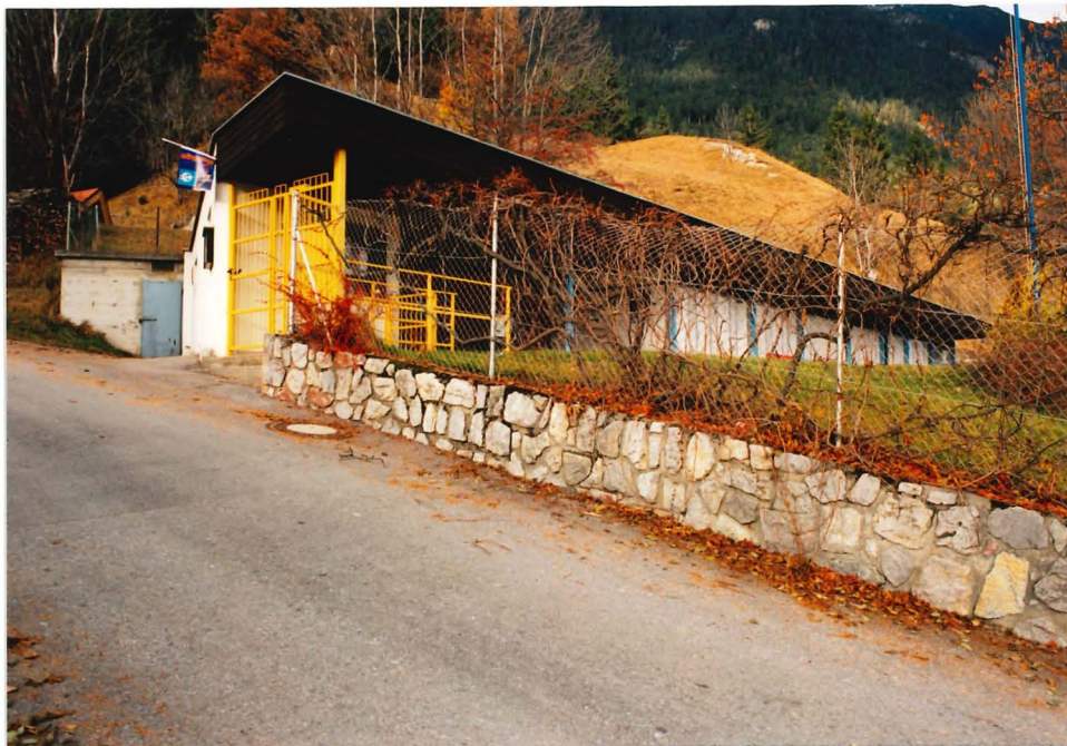
Hochbehälter an der Nordseite des Schwimmbades, Fassungsraum 10 Kubikmeter
