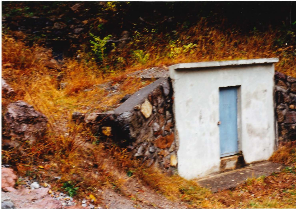
Untere Brunnenstube: Ausgangspunkt der Zuleitung zum Hochbehälter und zum Kurhaus
