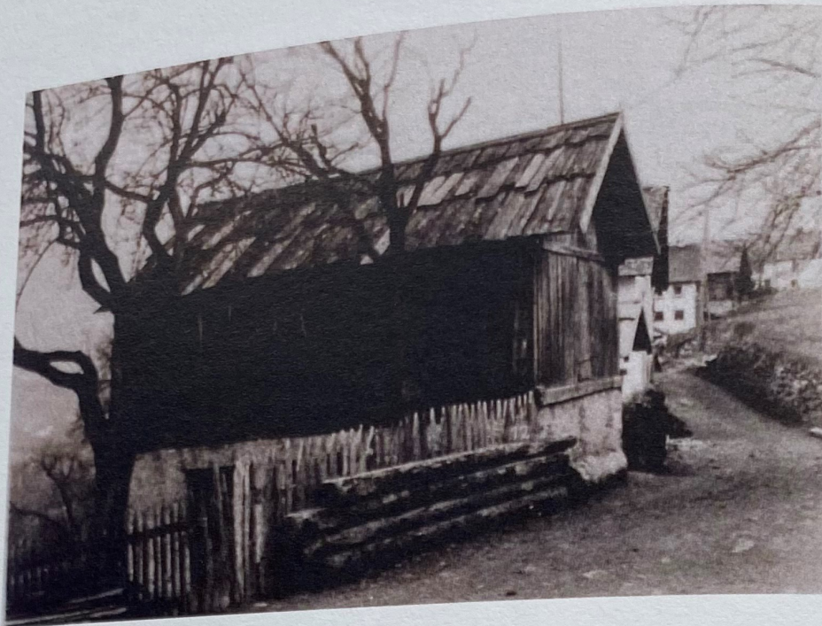
Hauptschmiede vor Abriss 1968, seit 1947 nicht mehr in Betrieb – mit Blick in die Außergasse
