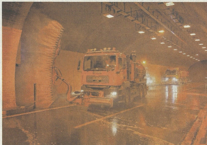
Maschinell und per Hand werden die großen Tunnel im Oberland von Asfinag-Mitarbeitern gereinigt. Dabei kommt es zu Sperrungen. Foto: Asfinag
