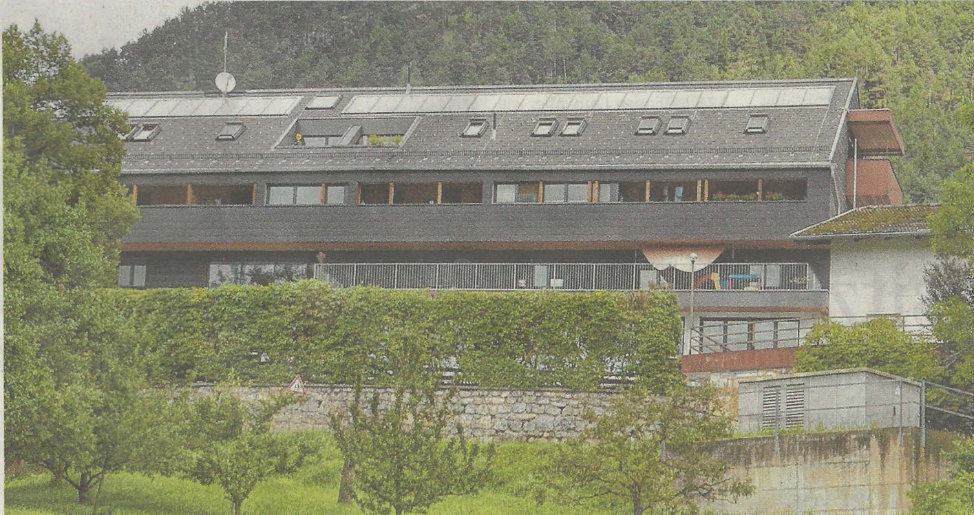
Zu der Photovoltaikanlage auf dem Karröster Gemeindehaus soll sich eine zweite auf dem Dach des Veranstaltungszentrums gesellen.
