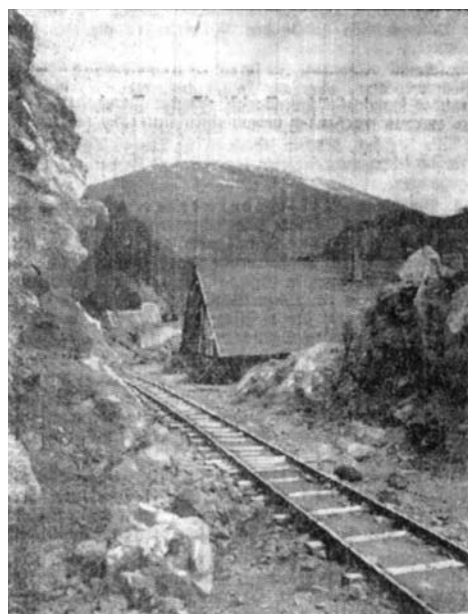
Foto: Zwischen dem Felshang und den Häusergiebeln von Brennbichl wird durch Sprengungen die neue Straße gebahnt.
