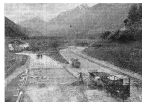
Foto: Im Sattel oberhalb von Brennbichl gabelt sich die Straßentrasse: rechts geht es im sanftem Gefälle nach Imst, links fällt die Straße zum Bahnhof Imst ab und leitet dann ins Pitztal weiter.
