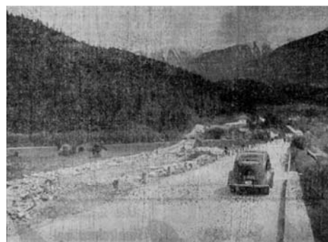
Foto: Gleich hinter Imst führt die im Bau befindliche neue Reichsstraße, links von der alten, Richtung Bahnhof führende Straße abzweigend und Brennbichl umfahrend, in mäßiger Steigung am Berghang empor.
