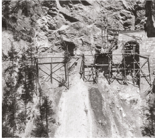
3. Westliches Tunnelportal mit Baugerüst – Zuerst wurden die Stützmauern und die Bögen errichtet und dann mit Hilfe der „Loren“ hinterfüllt., 4. Westliches Tunnelportal mit Baugerüst, 5. Schwere Arbeit bei Tunnelausbruch, vor dem Einbringen des Betons musste der Fels abgestützt werden
