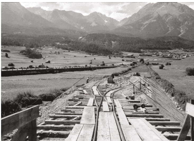
9. & 10. Behelfsbrücke überm Piger zur Schüttung des Straßendamms bis zur Einmündung in die Langgasse im Bereich der heutigen Tankstellen. Sehenswert die unverbaute Langgasse, zur Orientierung Bildmitte oben der Turm der heutigen Landesmusikschule ehemals „Stapf Villa“.
