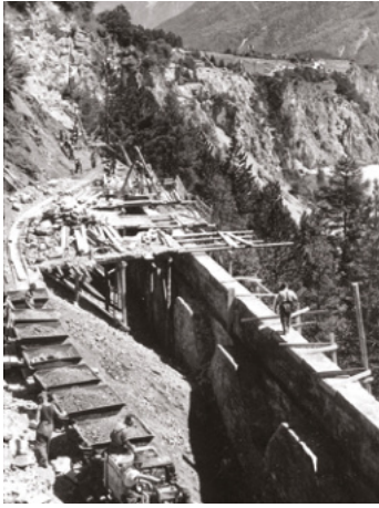
3. Westliches Tunnelportal mit Baugerüst – Zuerst wurden die Stützmauern und die Bögen errichtet und dann mit Hilfe der „Loren“ hinterfüllt., 4. Westliches Tunnelportal mit Baugerüst, 5. Schwere Arbeit bei Tunnelausbruch, vor dem Einbringen des Betons musste der Fels abgestützt werden
