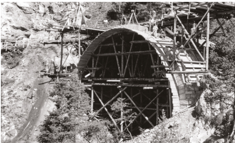
6. Westliches Tunnelportal wird mit Steinen gemauert, 7. Bau der Pitztaler Straße, neuer Zubringer zum Bahnhof. Gut erkennbar der Romedihof und die Rochuskapelle. In Brennbichl gut zu erkennen das Bauernhaus von Julian Fink, gegenüber die alte Wagnerei Reheis, nur das Dach sichtbar. Rechts im Bild der Bau der „Romedikurve“ und die Auffahrt zur alten Bundesstraße.
