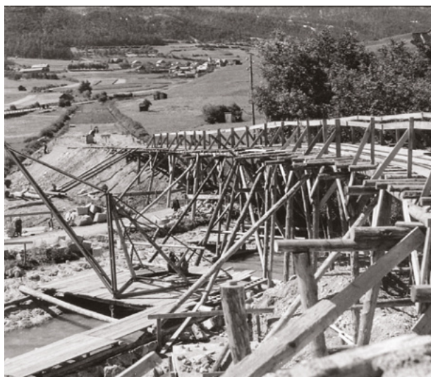
9. & 10. Behelfsbrücke überm Piger zur Schüttung des Straßendamms bis zur Einmündung in die Langgasse im Bereich der heutigen Tankstellen. Sehenswert die unverbaute Langgasse, zur Orientierung Bildmitte oben der Turm der heutigen Landesmusikschule ehemals „Stapf Villa“.
