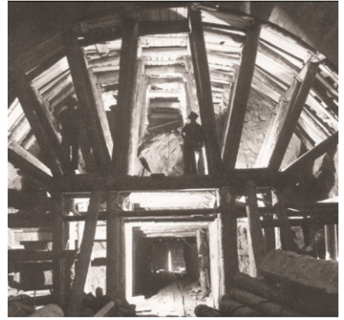
3. Westliches Tunnelportal mit Baugerüst – Zuerst wurden die Stützmauern und die Bögen errichtet und dann mit Hilfe der „Loren“ hinterfüllt., 4. Westliches Tunnelportal mit Baugerüst, 5. Schwere Arbeit bei Tunnelausbruch, vor dem Einbringen des Betons musste der Fels abgestützt werden
