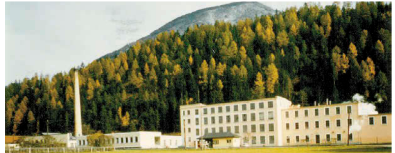
Das Fabriksgebäude von Jenny & Schindler in der Imster Fabriksstraße während der 70er Jahre: Der Schornstein wurde 2004 kontrolliert gesprengt, das Gebäude selbst wenig später abgerissen.
