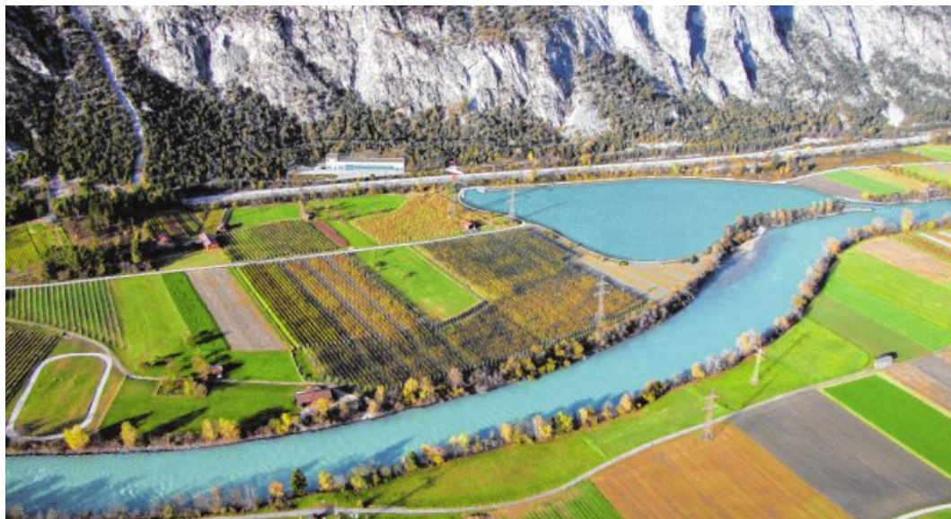
So sollen das Krafthaus Haiming und das Unterwasserbecken zum Schwallausgleich aussehen. Visualisierung: Tiwag
