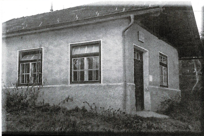
Das alte Betriebsgebäude der Weberei Schatz
