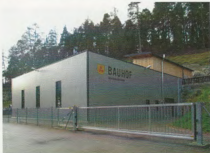
Der neue Bauhof ist Werkstätte für die Gemeindearbeiter und Garage für die dorfeigenen Gerätschaften.
