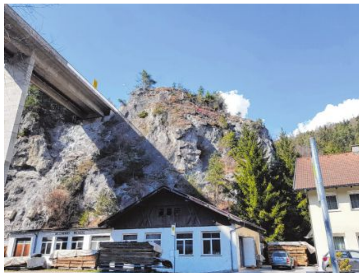
Der Schutzwald oberhalb des Karröster Weilers Königskapelle unterhalb der Pitztalbrücke wird verjüngt und klimafit. Foto: Partl
