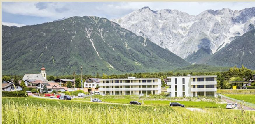
Foto: GHS Bau
