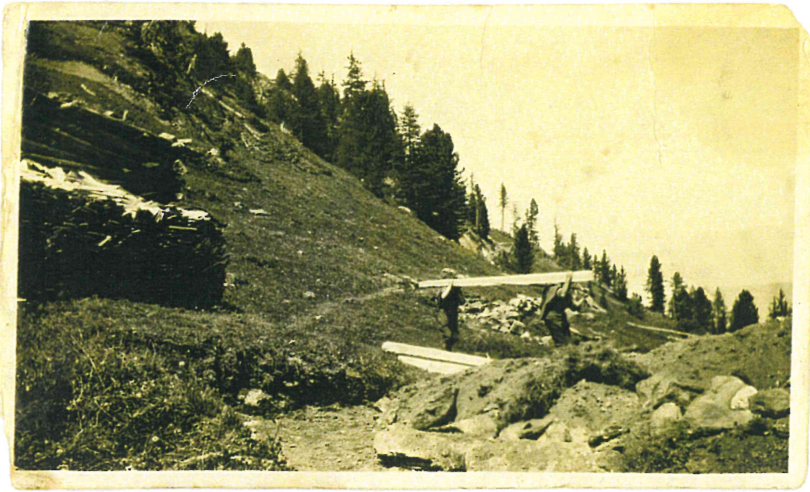
Der Bau beginnt
