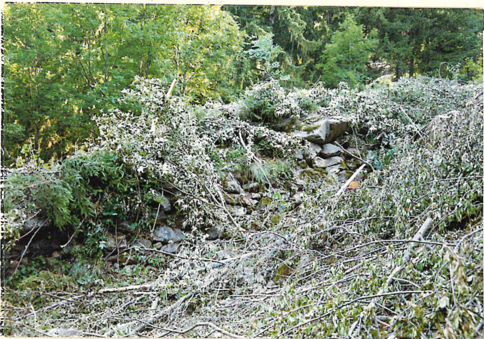
Fotos: Alte Verbauung am Holderbach
