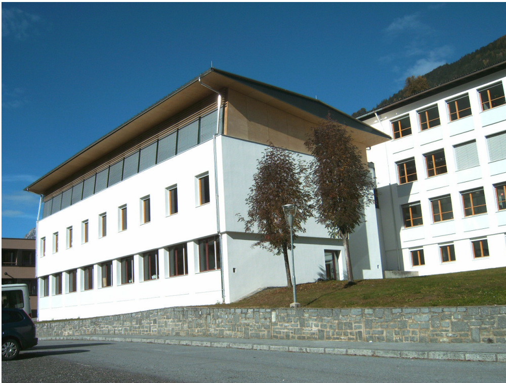
Anbau nach der Aufstockung 2002
