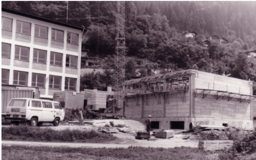
Anbau des Turnsaales
