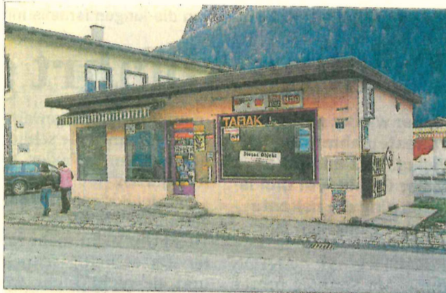
Kiosk wird abgerissen
