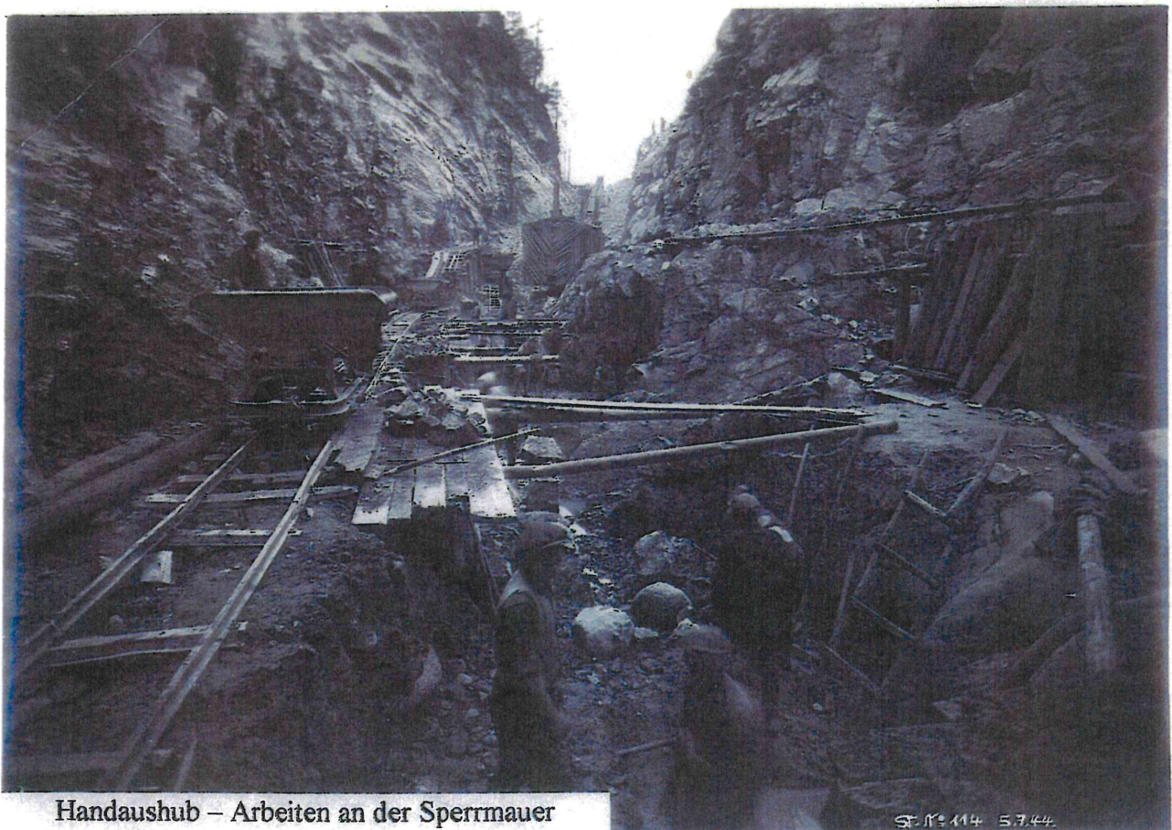
Baugrube der Sperrmauer Beginn der Handschachtarbeiten
