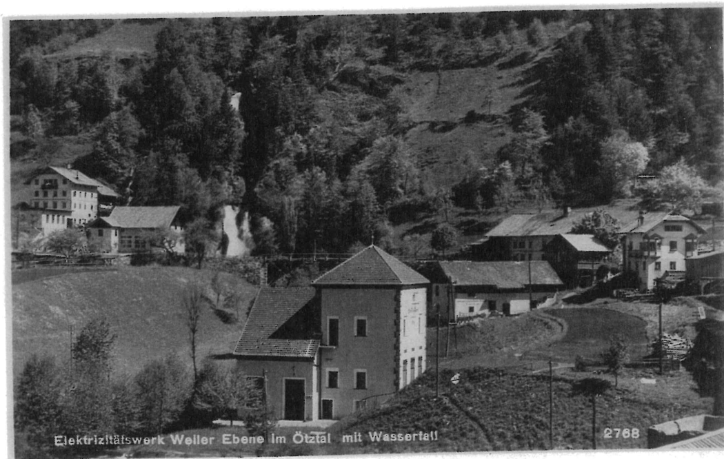
Foto : Das von der Gemeinde Oetz 1925 erbaute Kraftwerk in der Ebene
