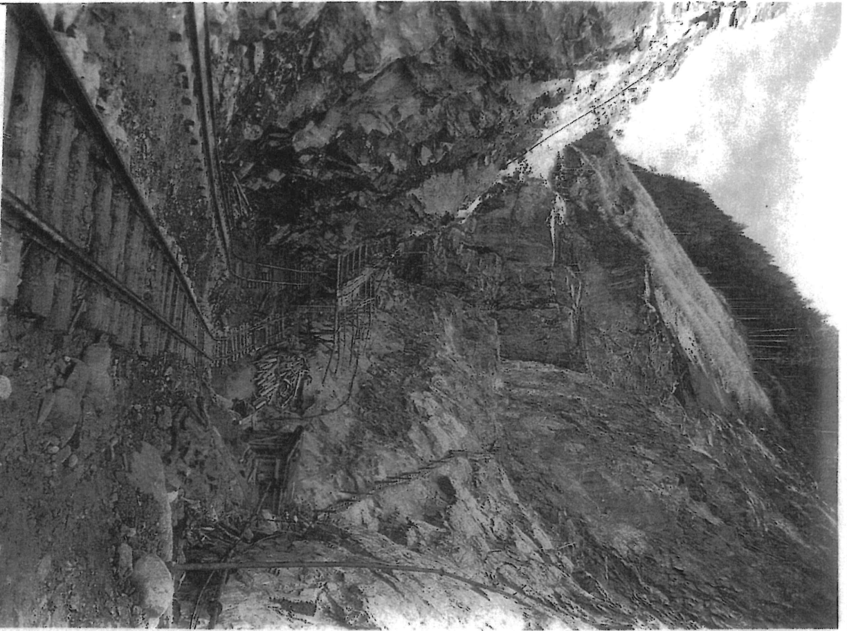
Gleisanlage in die Sperrenbaugrube
