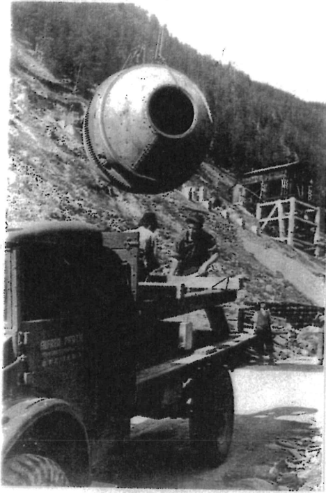
Fotos : Abtransport eines Kugelmischers Baustelle Stuibenbachsperre
