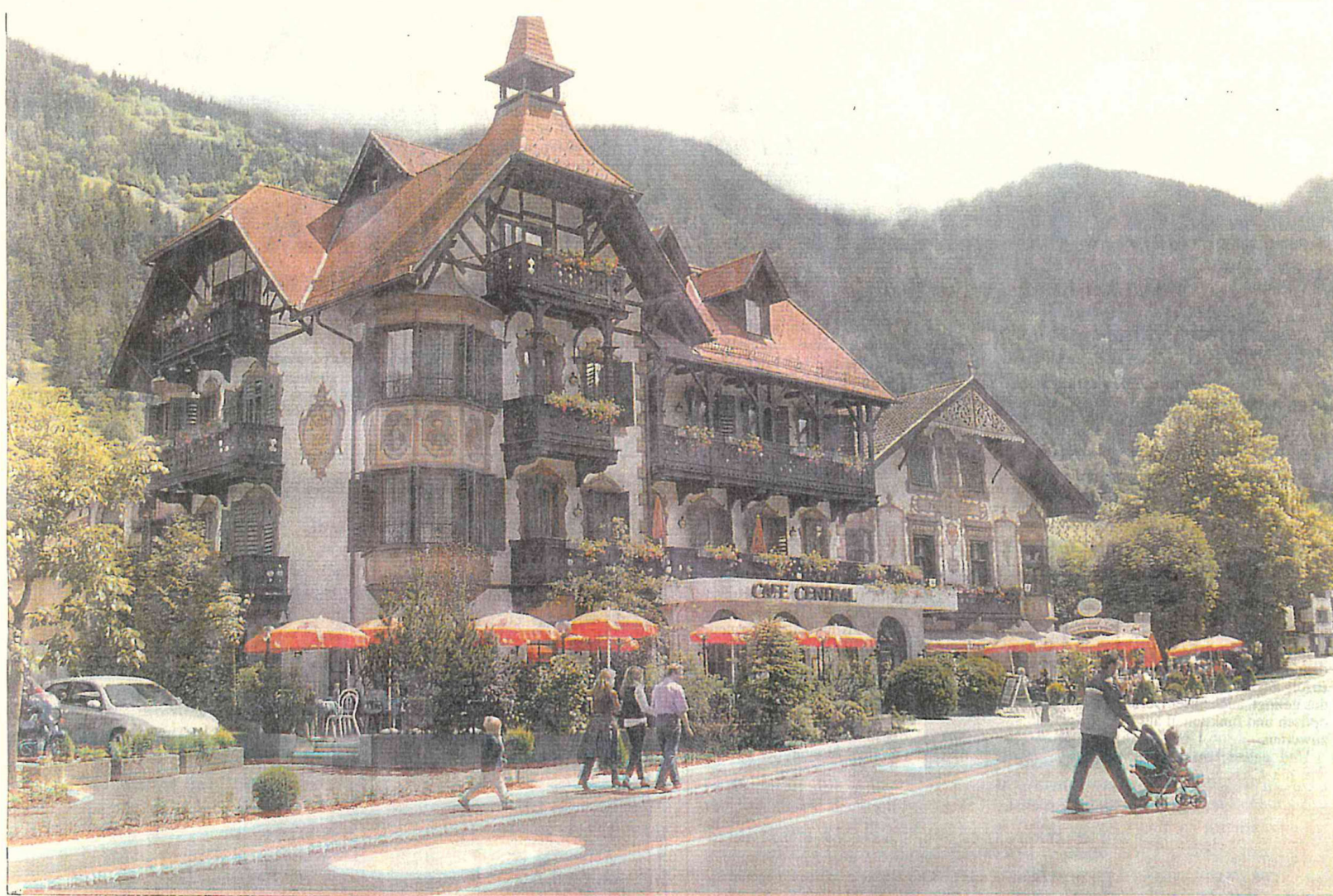
Gebremster Durchzugsverkehr, ausgeweiteter Fußgängerbereich: Das Oetzer Dorfzentrum (im Bild das Posthotel Kassl) hat wesentlich an Attraktivität gewonnen.
