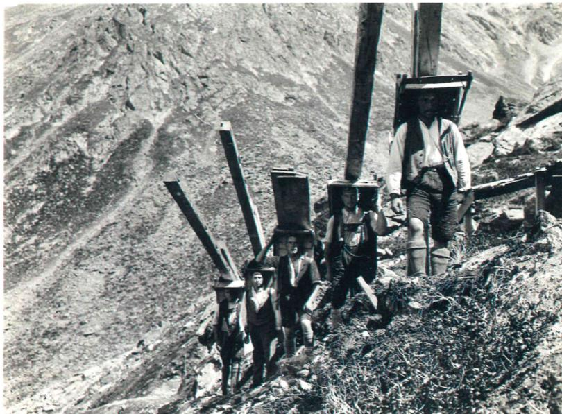
Einer der größeren Aufträge für die junge Firma Thurner war 1913 der Bau der Bielefelder Hütte. Dieses höchst interessante Bild zeigt, wie Arbeiter mit Kraxen jeden einzelnen Balken sowie Bretter usw. auf den Berg hinauftragen - in Lederhosen und Kniestrümpfen. Im Zeitalter der Hubschraubertransporte kann man angesichts derartiger Leistungen nur mehr staunen.
