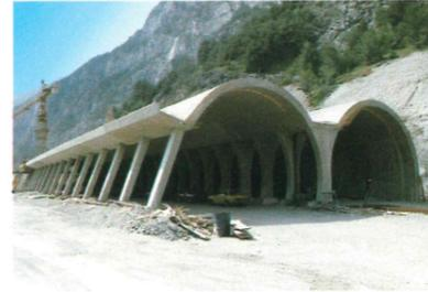
Der Bau der Autobahnabfahrt Ötztal erwies sich als äußerst schwierig. Auf dem Bild erkennt man, daß der Mittelteil im freien Vorbau errichtet wird. Soeben ist ein Mischwagen (im Bild rechts) dabei,
