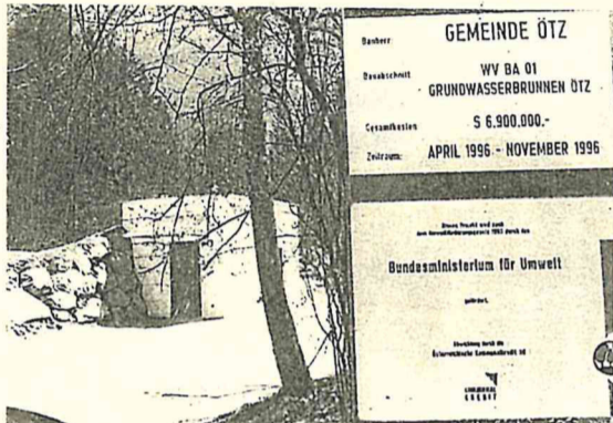
Sieben Mio. Schilling verschlang der Grundwasserbrunnen Oetz/Grube, 18 Sekundenliter werden gefördert.
