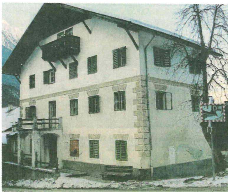
Land trägt die Sanierungskosten. Die Pläne für einen Neubau wurden nach Einwand des Denkmalamtes gestoppt. Foto: Geisler
