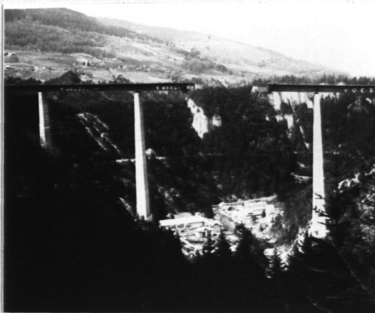
Europabrücke vor der Fertigstellung
