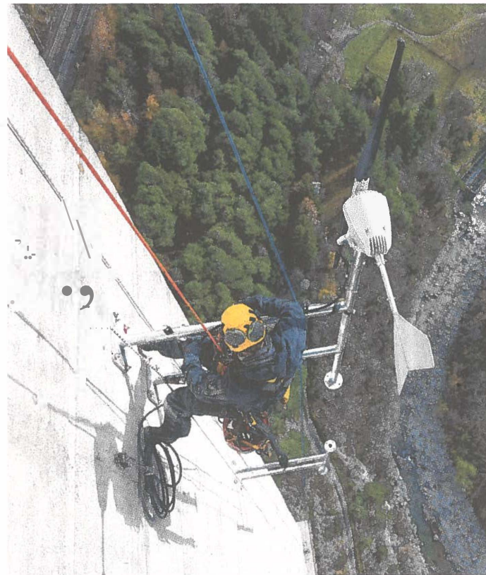
Zehn Tage dauerte die herausfordernde Montage der Mikrowindanlagen in
