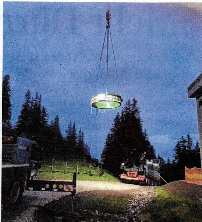
Am Kofel wird nahezu rund um die Uhr gearbeitet. Der Ring des Antriebsmotors wurde mittels Spezialkran aus der Station gehoben. Fotos: Patscherkofelbahn
