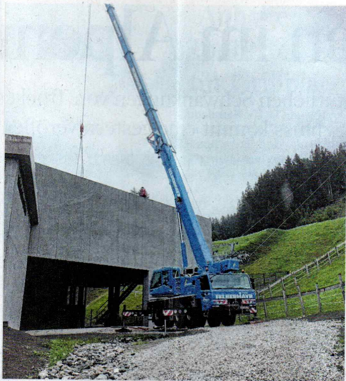
Am Kofel wird nahezu rund um die Uhr gearbeitet. Der Ring des Antriebsmotors wurde mittels Spezialkran aus der Station gehoben. Fotos: Patscherkofelbahn
