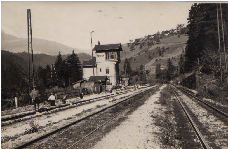
Der Bahnhof Patsch um 1925. Es wird gerade an der Elektrifizierung gebaut
