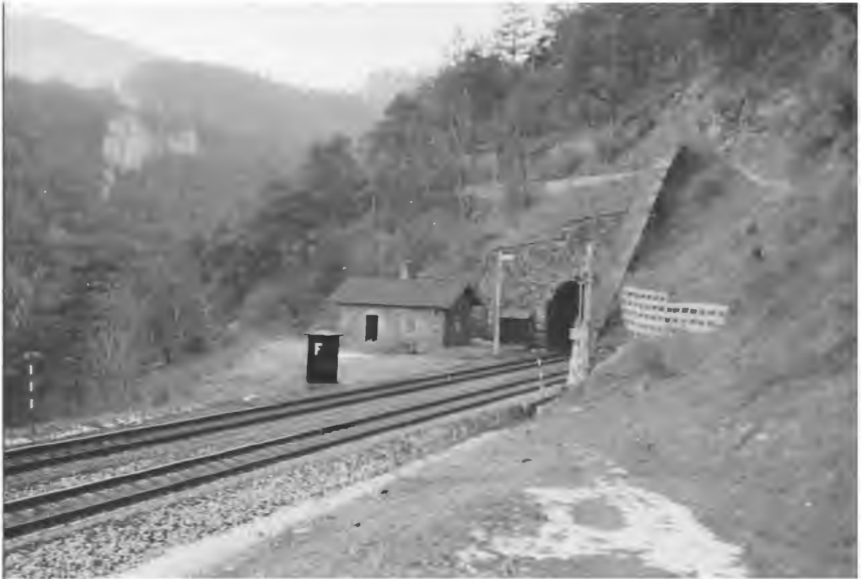
Bahnwächterhaus Pittracher beim Patscher Tunnel. Im Vordergrund der aufgelassene Weg zum Sillwerk. Hier war ein beschränkter Bahnübergang. Der Bahnwächter bediente den Schranken und die Signalanlage.
