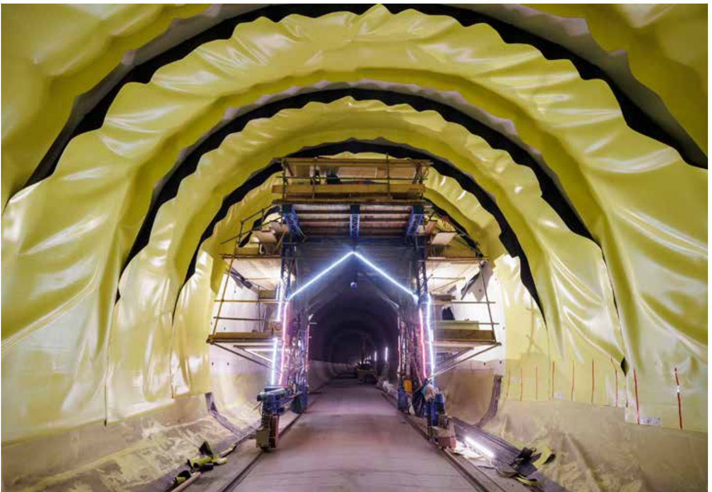
BU Sillschlucht-Pfons / Gewölbeauskleidung im Baulos Ahrental bei Innsbruck: Verlegung der Abdichtungsschicht / © BBT SE / Hetfleisch
