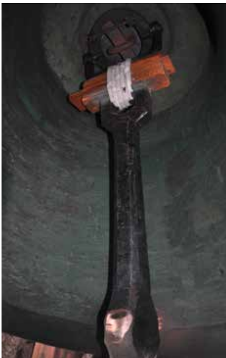
Die Befestigung des Klöppels mit Lederriemen.
