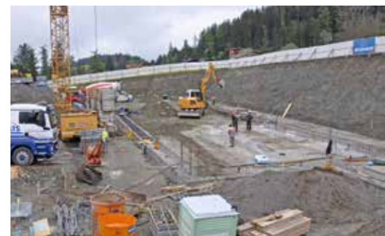
Arbeit an der Bodenplatte
