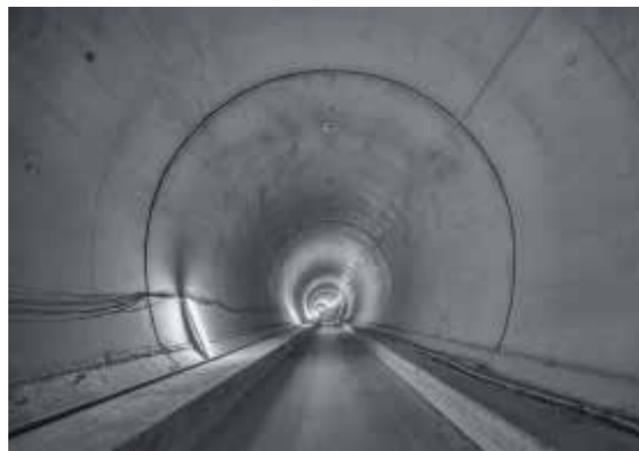
Hauptfahrröhre des Brenner Basistunnels mit fertiger Innenschale.
