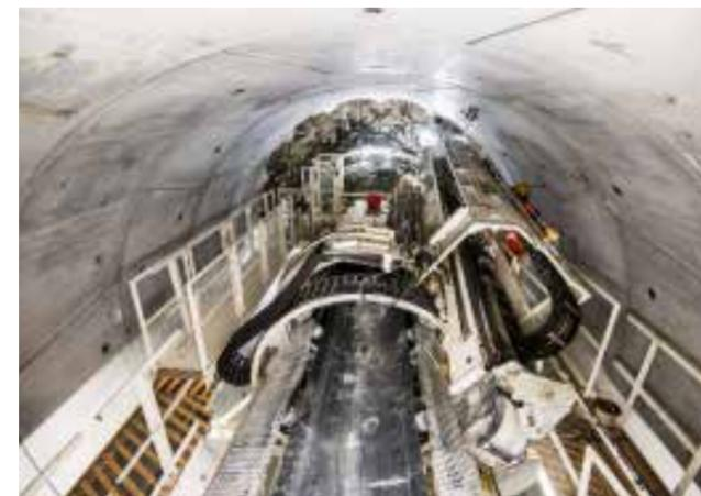
Für den Vortrieb kommen Tunnelbohrmaschinen zum Einsatz.
