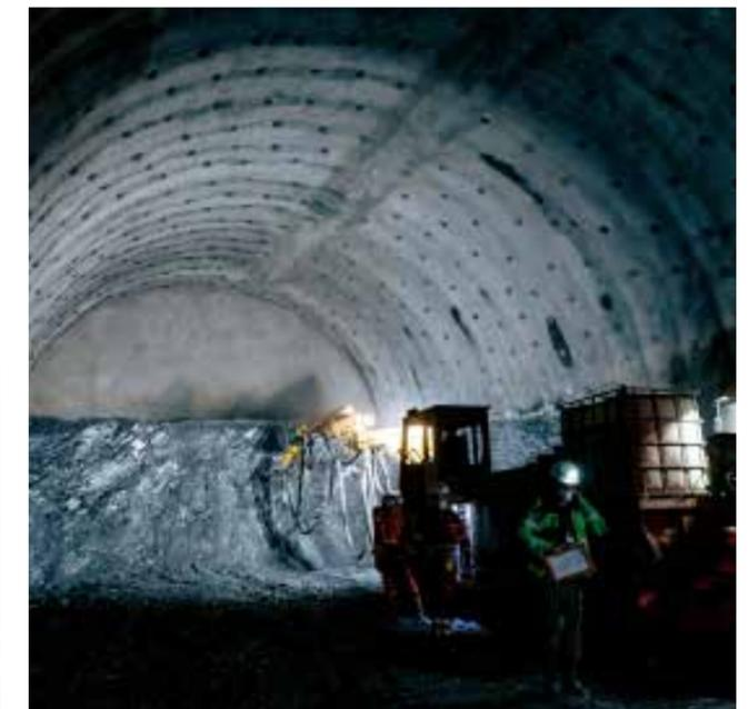
Das BBT-Tunnelsystem entsteht zu 50% mittels Sprengvortrieb. Fotos und Grafik: BBT SE
