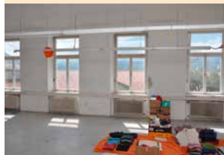
Großes Klassenzimmer vor dem Abbruch Foto: Chronik
