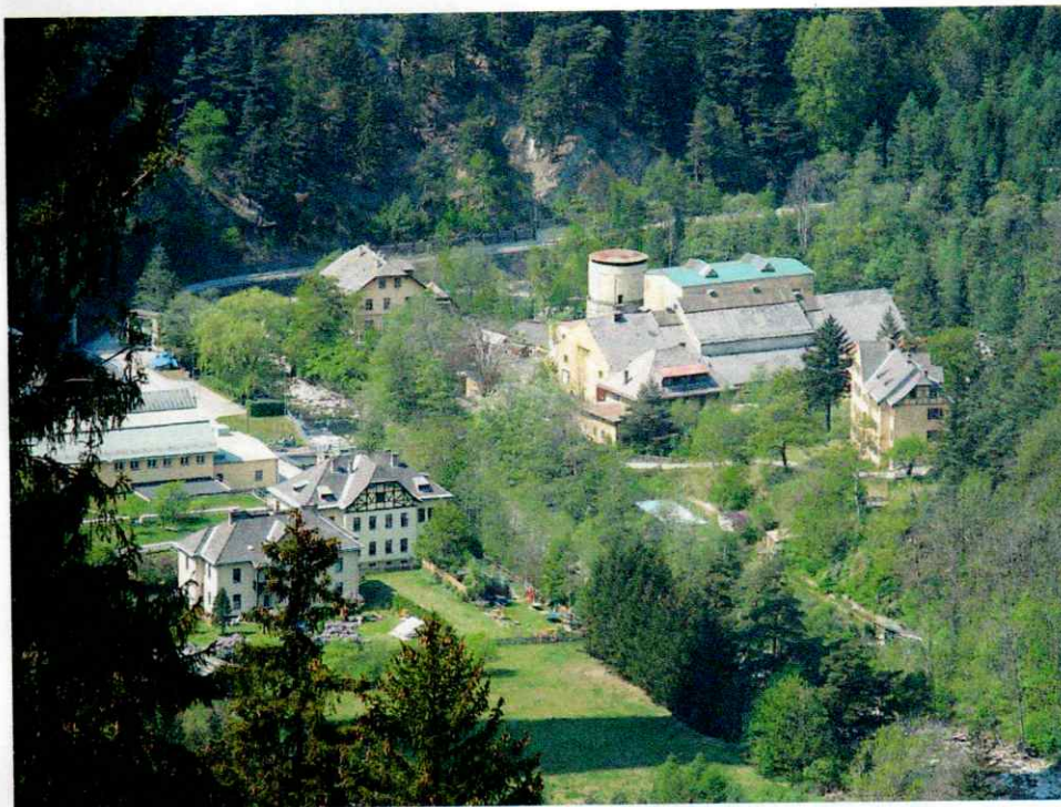
Sillwerk: Bildmitte: Sill, rechts: Planseewerk (Ehemaliges Salpeterwerk), links E-Werk, Arbeiterwohnhäuser
