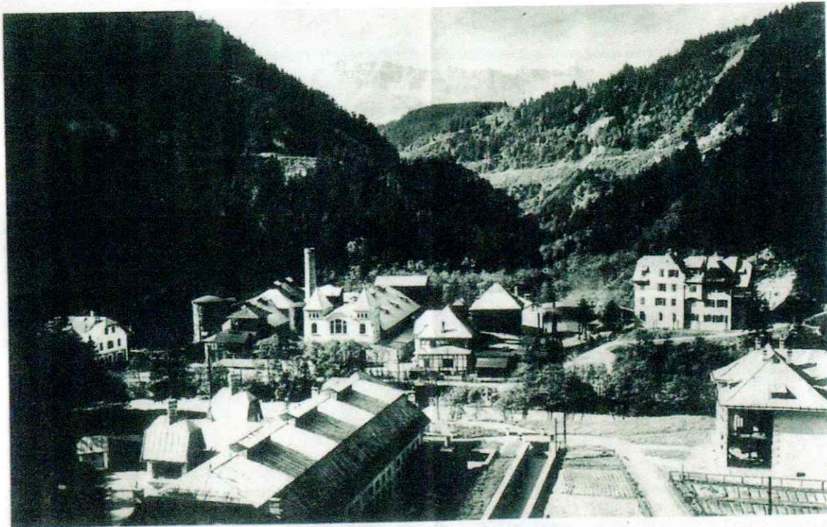
84 Gesamtansicht der Sillwerke.
