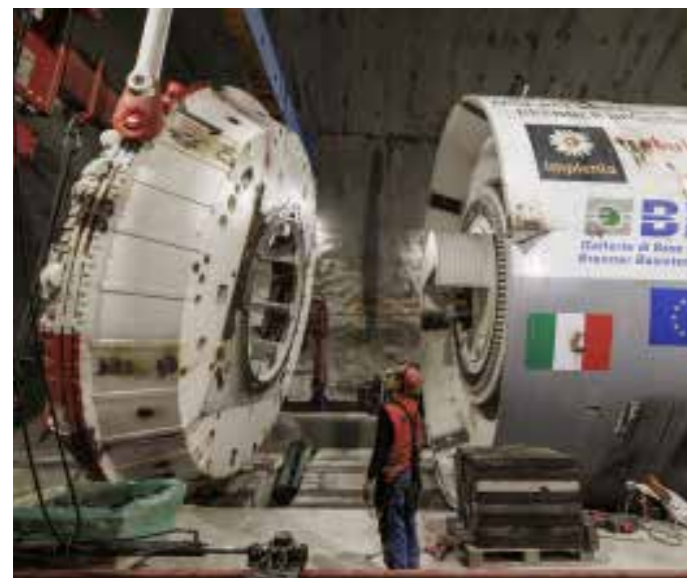
„Lilia“ – Zusammenbau der Tunnelbohrmaschine in der Montagekaverne Ahrental
