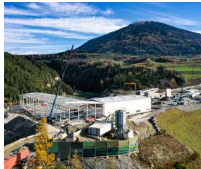
Tübbinghalle auf der Deponie Ahrental – mit Blick auf die Gemeinde Patsch.
