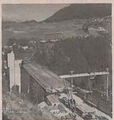
Europabrücke Im Bau, Aufnahme VOR 1962 foto, runlungRlwJ1-Lou
