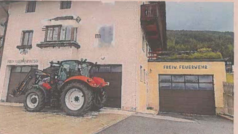
Nicht mehr zeitgemäß: Mit dem Neubau des Dorfsplatzes wurde die Freiwillige Feuerwehr ausgesiedelt.
